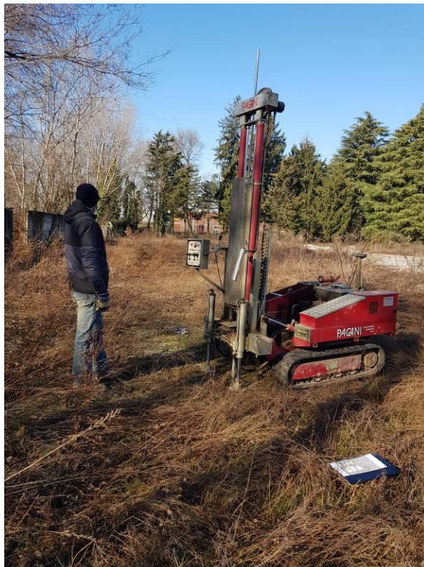
Foto 7: Posizionamento ed esecuzione prova DP 4
