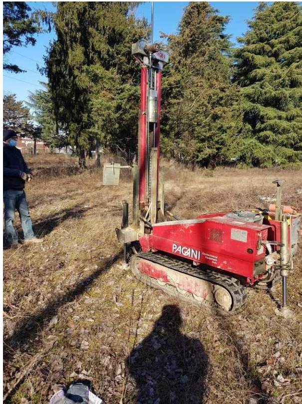
Foto 8: Posizionamento ed esecuzione prova DP 5
