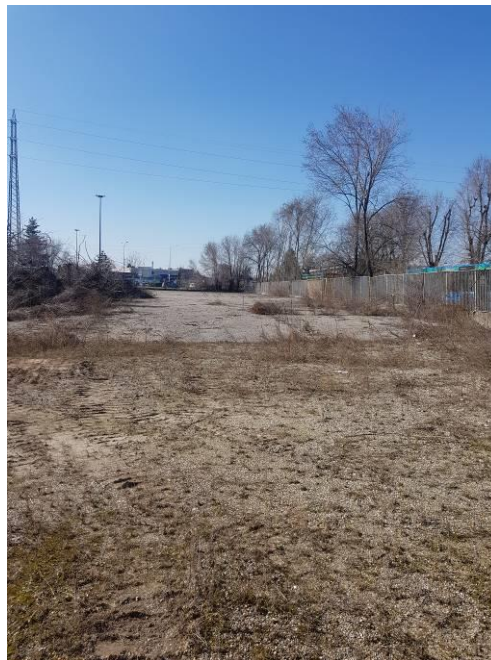
Foto 1, 2, 3: piattaforma in zona centrale, area depressa per esecuzione sbancamento e pavimentazione in cemento in zona nord ovest
