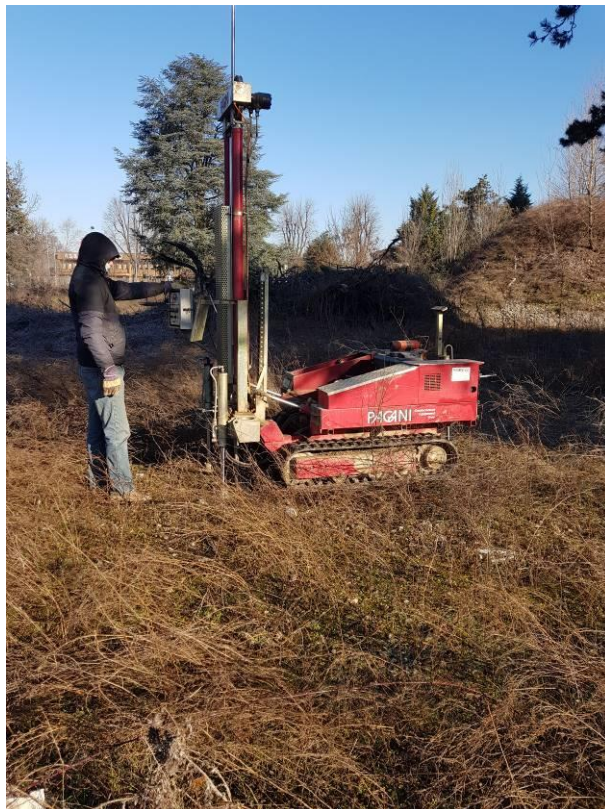
Foto 5: Posizionamento ed esecuzione prova DP 2
