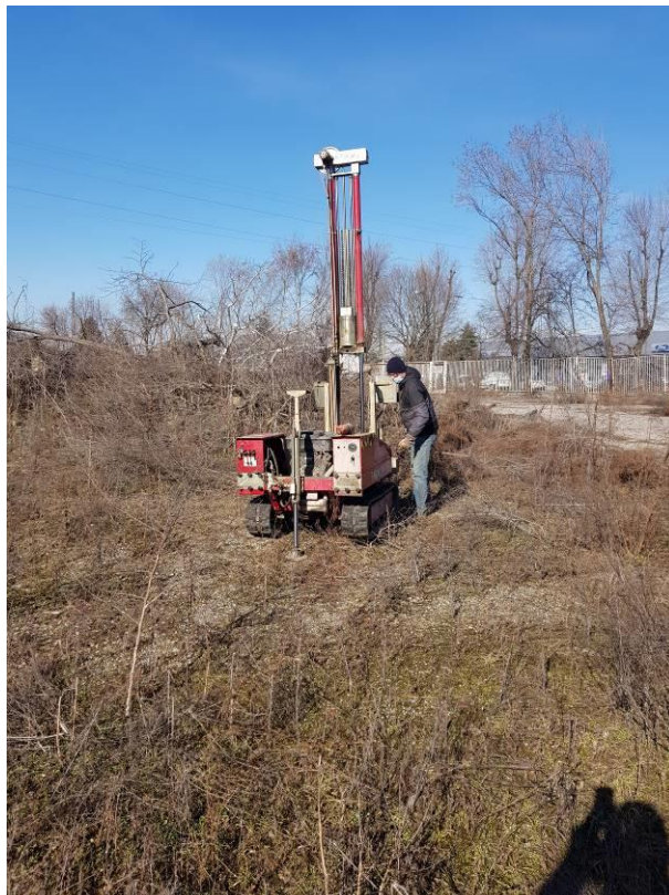
Foto 9: Posizionamento ed esecuzione prova DP 6
