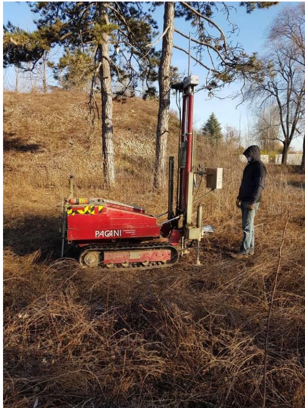
Foto 4: Posizionamento ed esecuzione prova DP 1
