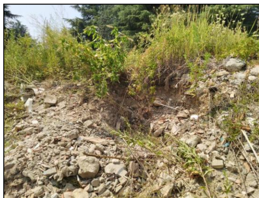
Apertura di trincee esplorative nel cumulo C03
