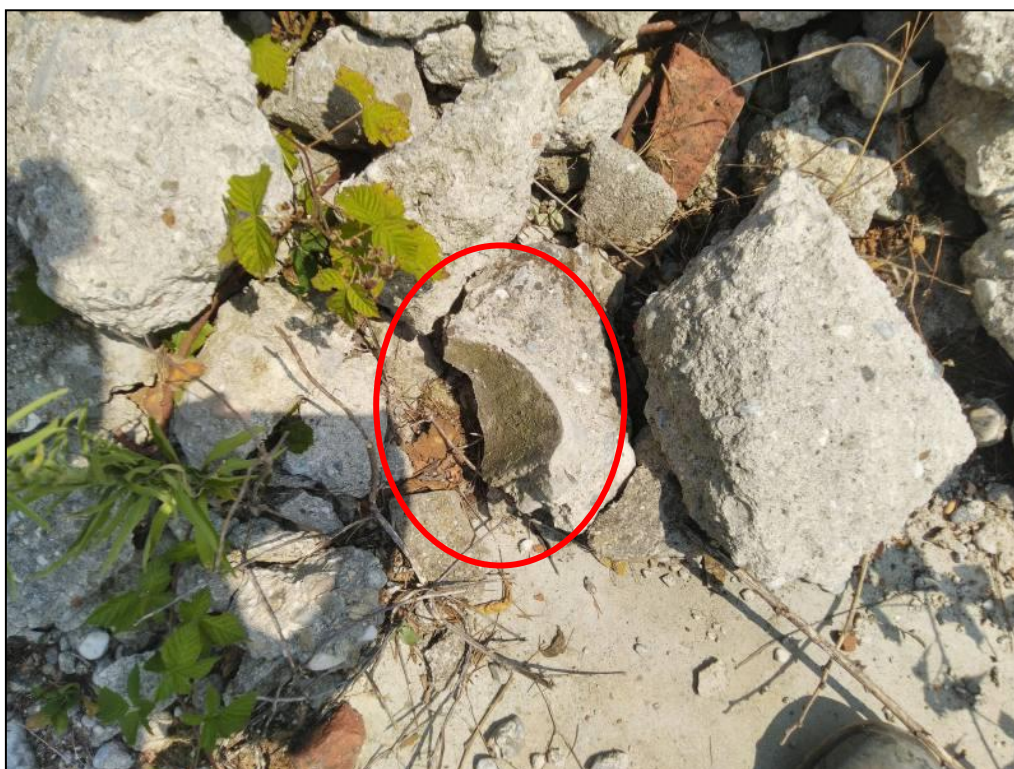
Frammento di condotta in MCA inglobato in una maceria di CLS
