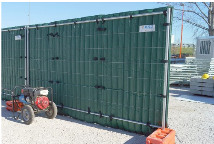
Figura: Barriera di cantiere fonoassorbente (tipologia)
