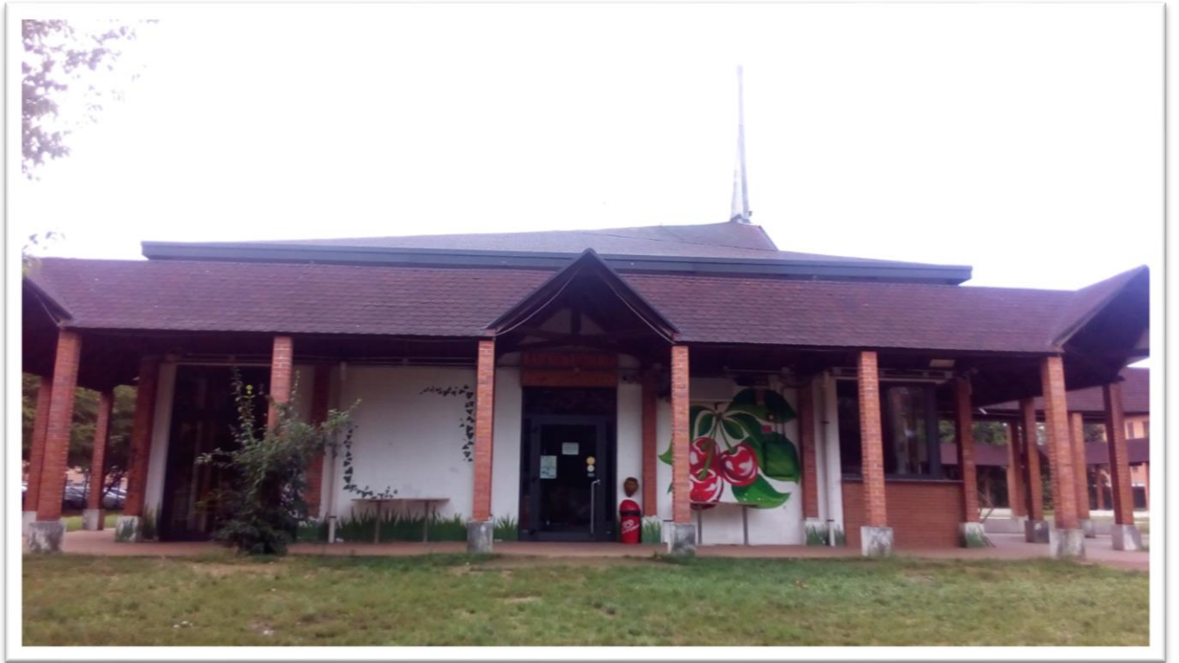
Figura 9 - ingresso bar, ristorante, merenderia
