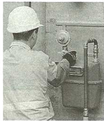
I contatori da sostituire (Blitz)
