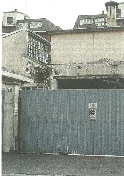
La ex Tintoria Olona dovrà essere recuperata
