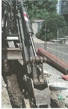
Nuovi scavi per le fognature
