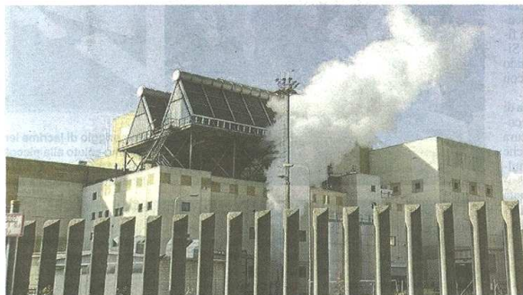
Entro domani i Comuni proprietari di Accam dovranno decidere se tenerlo acceso
