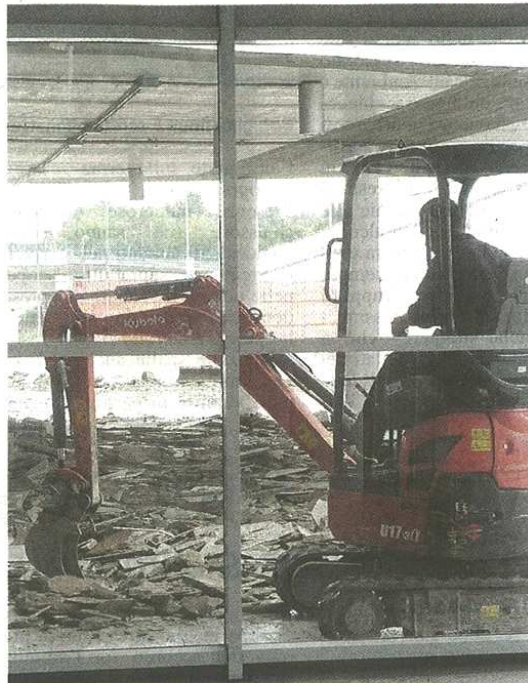
Ieri mattina gli operai incaricati da Ferrovie Nord Milano hanno cominciato a ristrutturare la pavimentazione già usurata della pur giovane stazione. A seguire tutti gli interventi necessari (foto Biliz)
