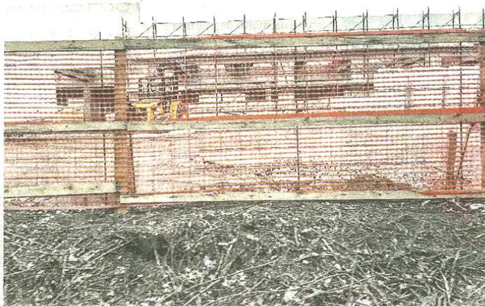
Il cantiere su cui sta sorgendo un nuovo discount nel territorio di Marnate (foto Blitz)
