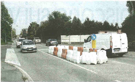
I new-jersey di via monsignor Colombo saranno sostituiti da isole spartitraffico (foto Blitz)
