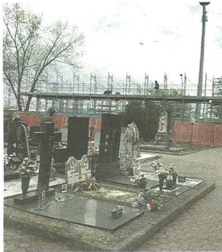
Il cimitero di Castellanza: sullo sfondo gli operai impegnati nella costruzione dei nuovi colombari (foto Blitz)
