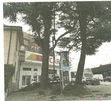
I lavori in viale Borri, sotto le piante che creano disagi sulla Saronnese. Nel testo, l'albero di viale Lombardia
