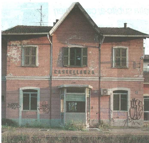
La vecchia stazione ferroviaria: lo stabile è ancora abbandonato e fatiscente
