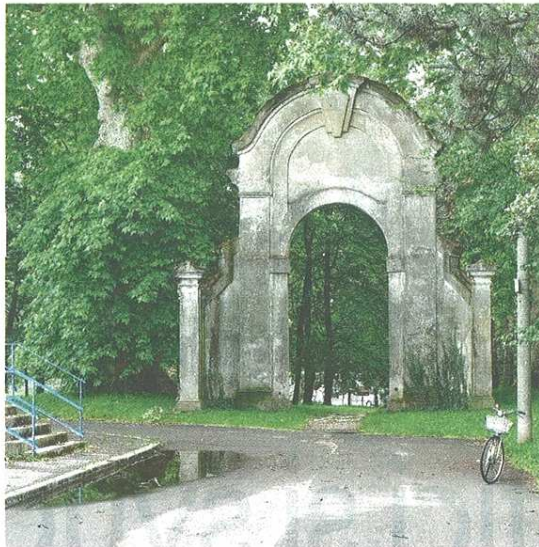
Una decina di telecamere saranno installate nel parco dei Platani
