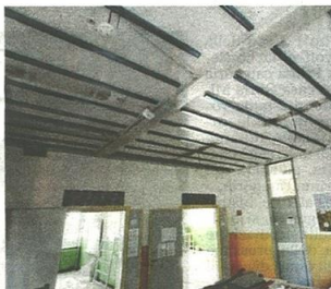
Alcuni dei lavori alla scuola primaria De Amicis di Castellanza
