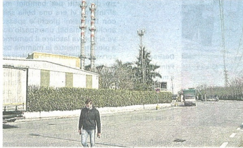
L'impianto termovalorizzatore dei rifiuti di Borsano
