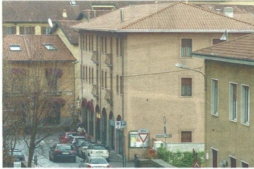
Le case comunali di via Soldini: il comune contro il problema della morosità
