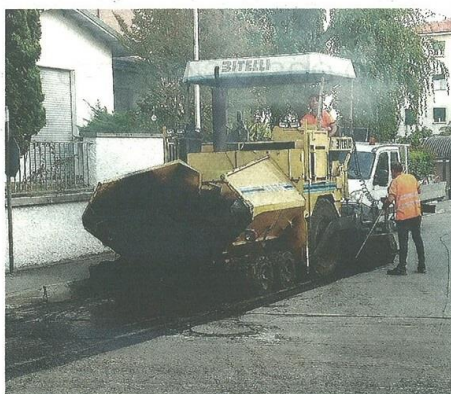
Al via il restyling di asfalti e marciapiedi nelle principali strade di Castellanza: investito circa mezzo milione di euro (foto B112)
