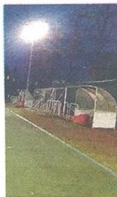
Il nuovo impianto
