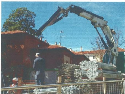
Montato nei giorni scorsi l'enorme ponteggio sulla torre di San Giulio, l'ottava più alta d'Italia
