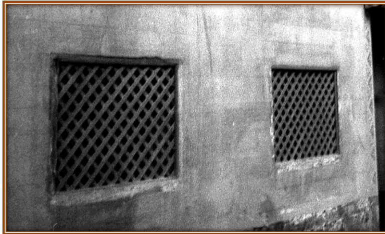
Le due grate prima del restauro
