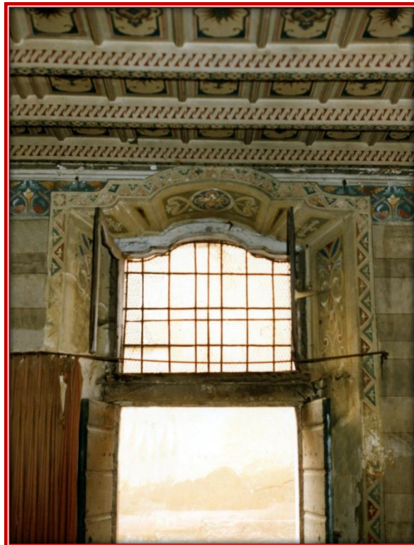
Porta di accesso prima del restauro
