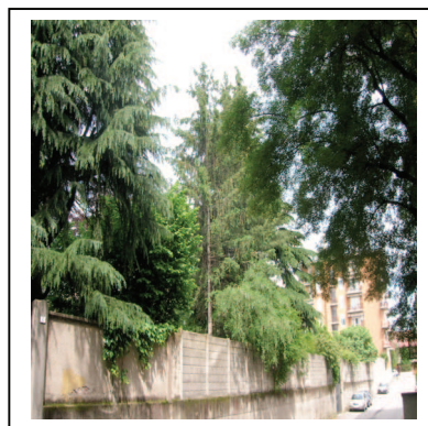
Foto 1 recinzione vista da via P.Micca
