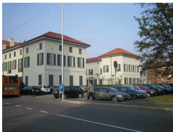
2. Parceggio, giugno 2007, veduta da viale Rimembranze
