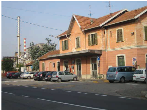
1. Parceggio, giugno 2007, veduta da via L. Pomini
